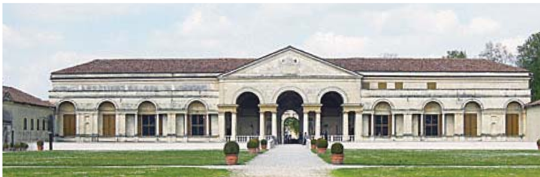
IL PALAZZO VISTO DAL CORTILE INTERNO
